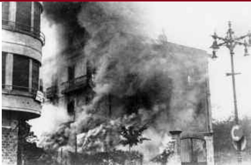
Incendio del 4 de septiembre de 1936 en el callejón de Miota, donde hoy está situada la entrada a la parroquia. Foto cedida por J.M. Castillo
